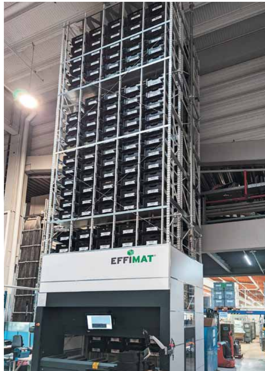
Die Kapazität des „Effimat“ beträgt bei EMZ 255 Lagerplätze für KLT. Davon werden 245 Plätze genutzt und 10 Plätze für intelligente Umlagerungs-/Verdichtungsprozesse freigehalten.
